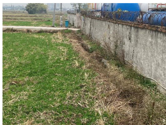
采气井场修建了排水沟
