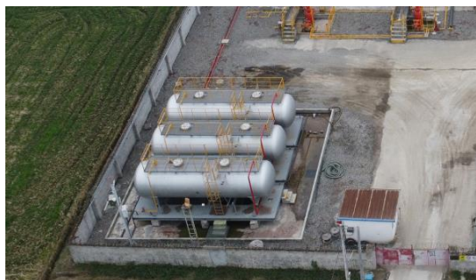
污水罐防渗及围堰
